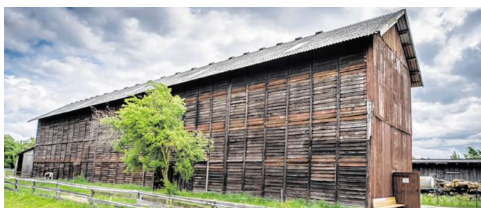
Die große Tabakschuppen im Klosterfeld ist die letzte ihrer Art in Lorsch. Das Gebäude wurde restauriert und wird für museale Zwecke ausgebaut. Am Sonntag kann es besichtigt werden. BILD: ZS
