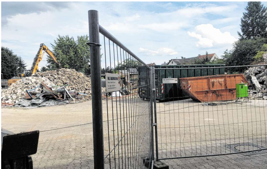
Im Neubau der gerade abgerissenen Einhäuser Mehrzweckhalle entstehen zusätzliche Klassenräume. Bis dahin wird in Schulcontainern unterrichtet.
