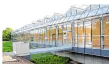
Der Parkplatz-Ost soll in der Nähe des gläsernen BIZ entstehen. ARCHIVBLD: LOTZ
