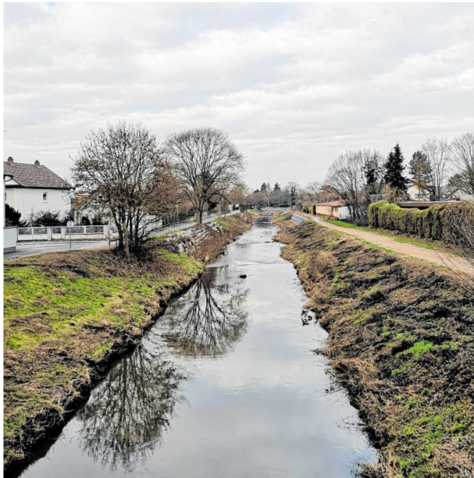
Die Sanierung und der Ausbau der Wege auf beiden Seiten der Weschnitz sind Stadtbauprojekte, die nach Ansicht der Verwaltung im Jahresantrag 2019 für eine Förderung vorgeschlagen werden sollten.
