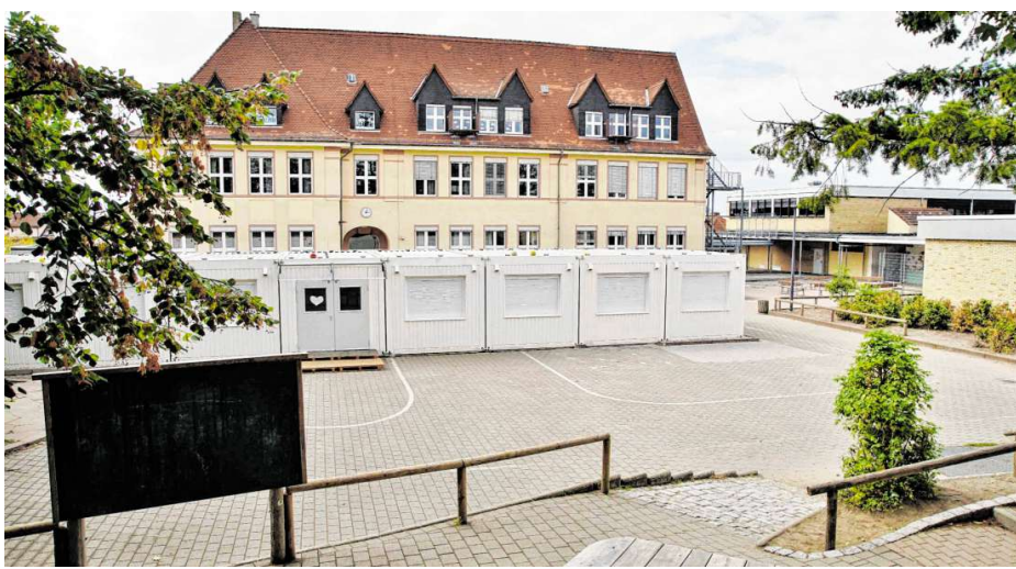
Die Wingertsbergschule soll saniert und fit für die Anforderungen der nächsten Jahrzehnte gemacht werden. Noch ist das Projekt aber erst ganz am Anfang. BILD: ZEILINGER
