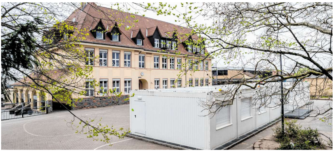
Zwei Schul-Container stehen schon seit Jahren im Pausenhof. Die Klassen, die sie nutzen, ziehen in Kürze aus. Die Container werden abgebaut und dann durch vier mobile Unterrichtsräume ersetzt. ARCHIVBILD: NEU
